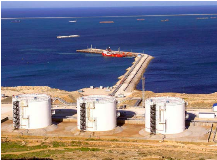
Стремление к развитию, усовершенствованию процессов отличает успешную компанию. Внедрение цифровых технологий, автоматизация рабочих процессов позволяют решать прежние задачи новым способом. Это значит, что оптимизируется работа компании, открываются дополнительные возможности
