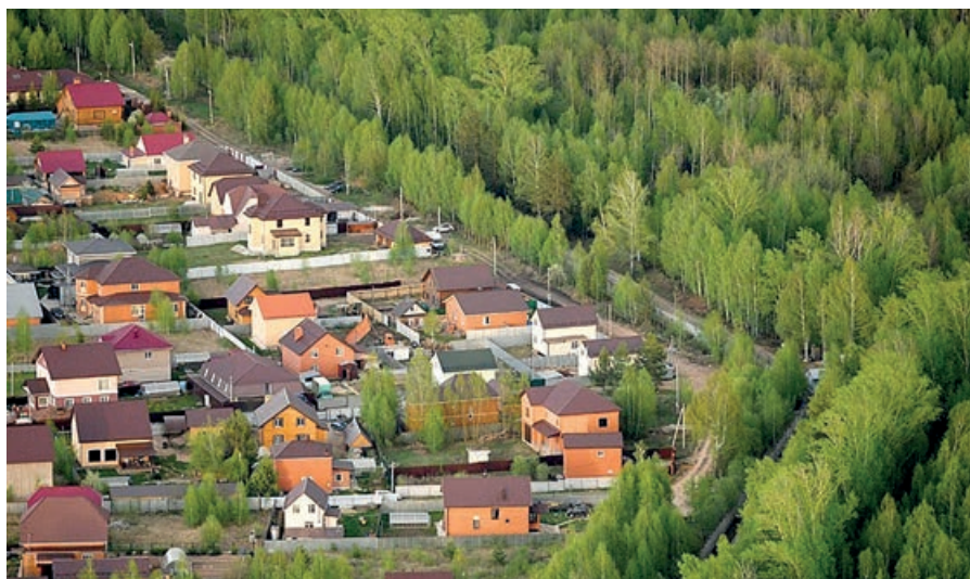
На конец июля в республике введено 2 млн 479 тыс. кв. м жилья, или 80% от годового плана, сообщает Минстрой РТ. По линии индивидуального жилищного строительства самый высокий процент выполнения — 90%
