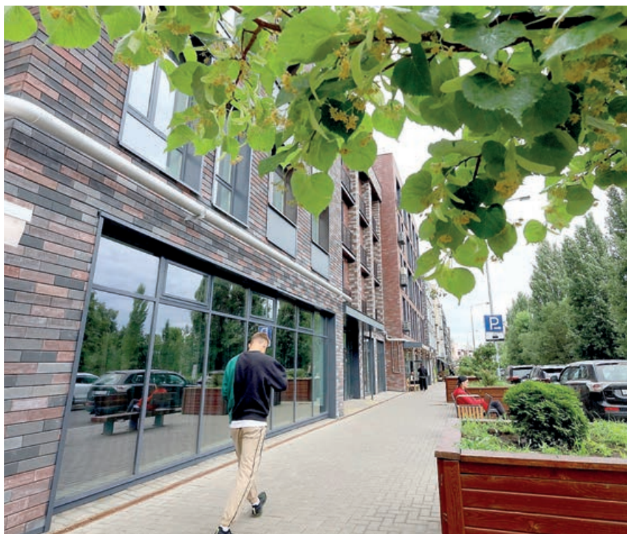
Сегодня в центре городов зачастую ведется точечная застройка, дома находятся рядом с парками и водоемами. Они камерные, с небольшим количеством квартир на этаже и функциональной планировкой
