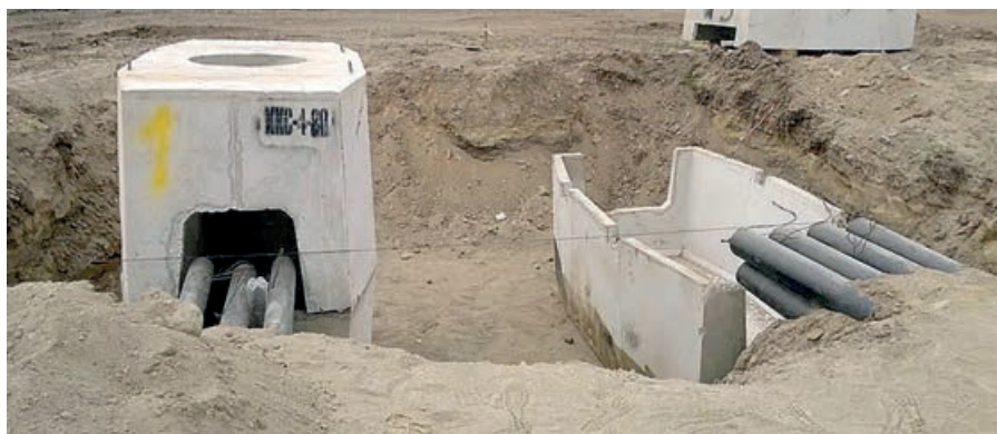
В новом своде правил определены требования к проектированию кабельных линий связи, кабельной канализации, обозначена глубина прокладки в грунте для кабельных линий связи
