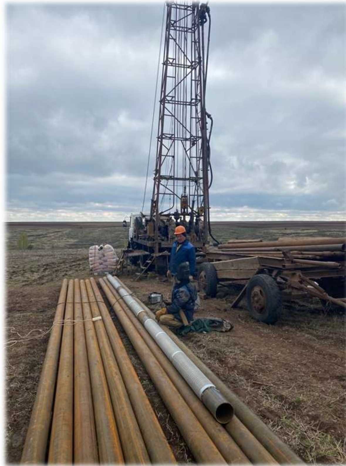
Строительство сетей водоснабжения в н.п.Балыклы, Кукморский район
